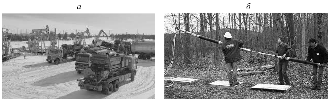
Рис. 1. Разномасштабные работы по нефтепромысловому (а) и инженерному (б) гидроразрывам горных пород с дневной поверхности
