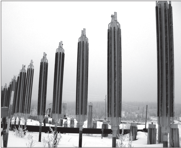
Рис. 8. Одиночные глубинные СОУ, установленные на плотине р. Ирелях (г. Мирный) [Системы..., 2014; Спасенникова, 2015].
