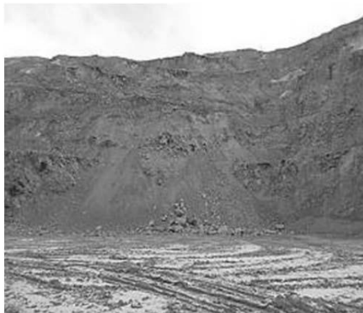
Рис. 1. Нестабильность откоса с обрушением породы
