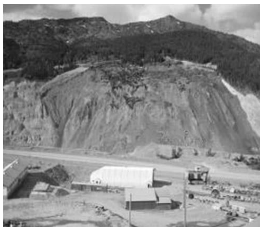
Рис. 2. Восточная часть обрушения борта карьера на месторождении Хакльберри [9]
