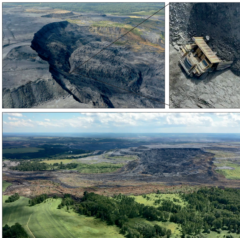
Рис. 1. Стоп-кадры видеосъемки Елбашинского отвала Колыванского угольного разреза через несколько дней после оползня [ https://youtu.be/KhXGpzuzPCU ].
