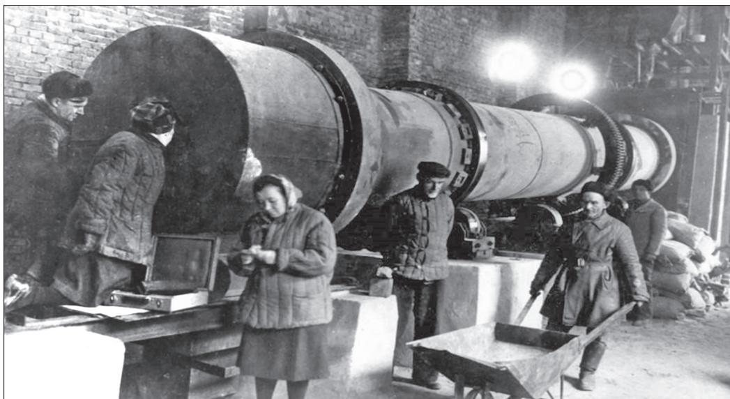
Рис. 1. Цех по переработке сподуменового концентрата (1950 г.).
