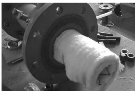
Рис. 5. Размещение алюмосиликатной ваты в трубопроводе
