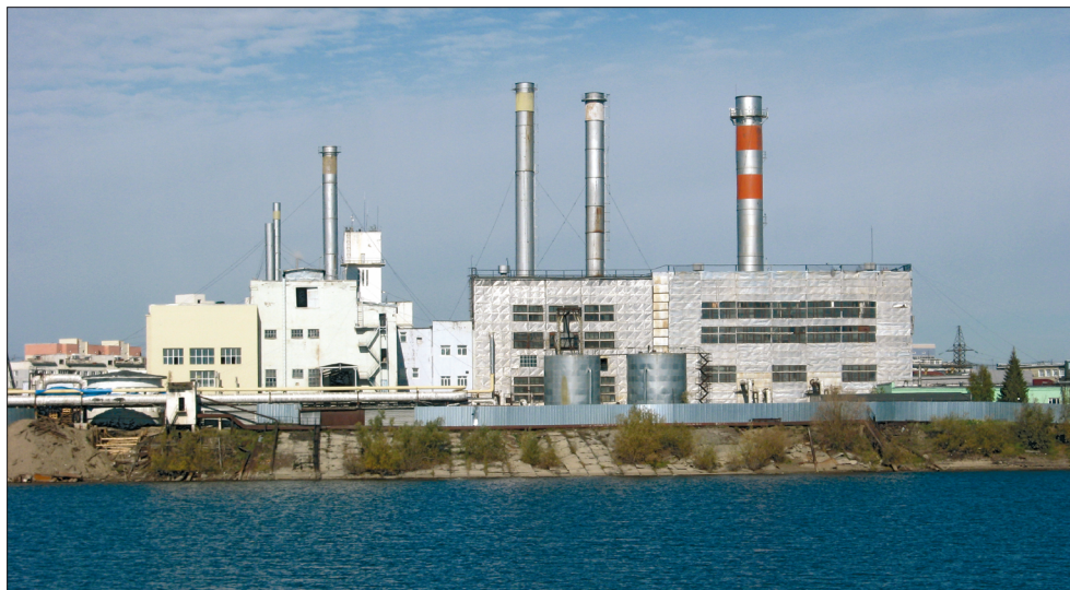
Рис. 1. Общий вид Якутской ТЭЦ.
