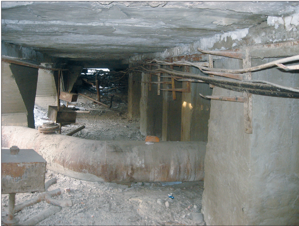
Рис. 6. Проветриваемое подполье под главным корпусом ЯТЭЦ.
