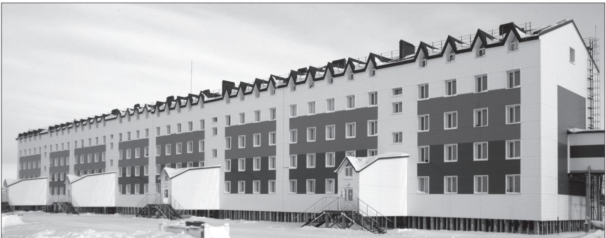
Рис. 2. Здание общежития на железобетонных сваях в зоне сплошного распространения ММП в пос. Харасавэй, п-ов Ямал.
