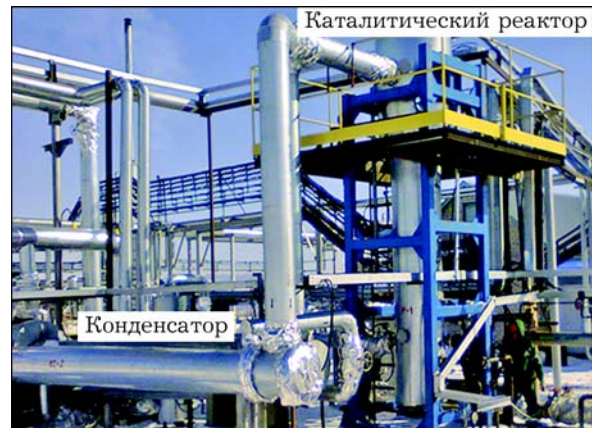
Рис. 1. Промышленная установка в Бавлинском газовом цехе.
