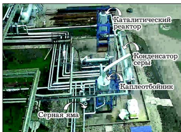
Рис. 2. Промышленная установка очистки ПНГ прямым каталитическим окислением ДНС-3010. АО “СМП-Нефтегаз”.
