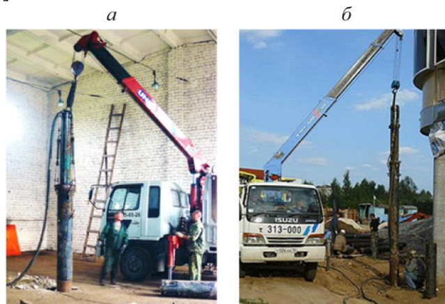
Рис. 1. Забивка трубчатых свай пневмоударными машинами: а — в стесненных условиях производственного помещения; б — ограждение колонны при локальной просадке грунта
