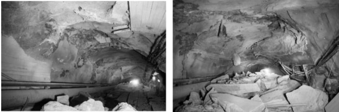
Рис. 5. Разрушения в выработках откаточного гор. +90 м Кукисвумчоррского крыла Кировского рудника в результате техногенного землетрясения
