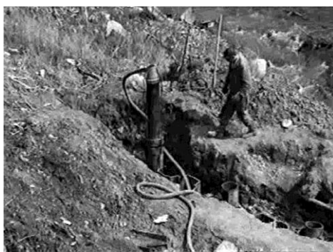
Рис. 2. Укрепление берега р. Ельцовка в Новосибирске шпунтом Ларсен-4 при помощи пневмомолота Т-130
