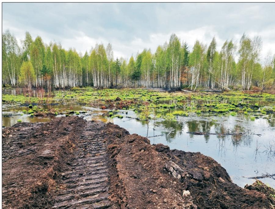
Рис. 5. Гребень плотины и образовавшийся перелив.
