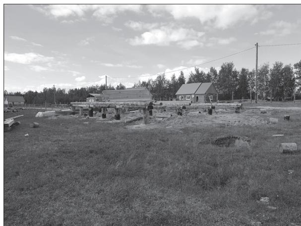
Рис. 10. Строительство дома на пятиметровых лиственничных сваях, микрорайон Первая пашня, с. Улахан-Ан.
