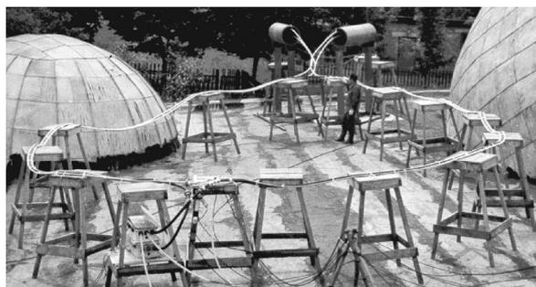
Рис. 3. Экспериментальная установка для возбуждения индукционным методом токов в экранах кабельной линии (МКГ размещены внутри сферической взрывной камеры)
