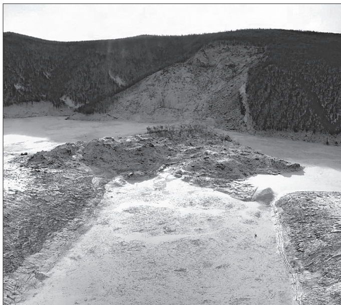
Рис. 1. Общий вид оползня на Бурейском водохранилище (фото В.И. Ким, 15.01.2019 г.).
