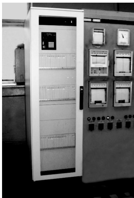
Рис. 4. Шкаф программируемых контроллеров на ГЩУ ТС 1.
