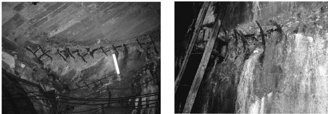
Рис. 1. Разрушение железобетонной крепи сопряжений шахтных стволов с дозаторной камерой на руднике “Интернациональный”
