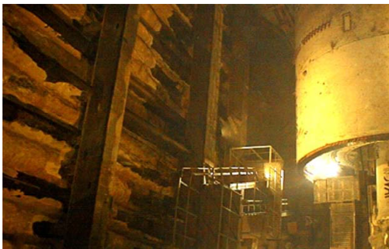
Рис. 8. Внутри камеры: вид сверху на горизонтальный проходческий щит (он справа) и подпорную стену из забитых в грунт труб диаметром 0.38 м
