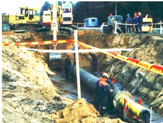
Рис. 7. Сооружение подземного перехода бестраншейным способом с использованием пневмомолота “Тайфун-740”
