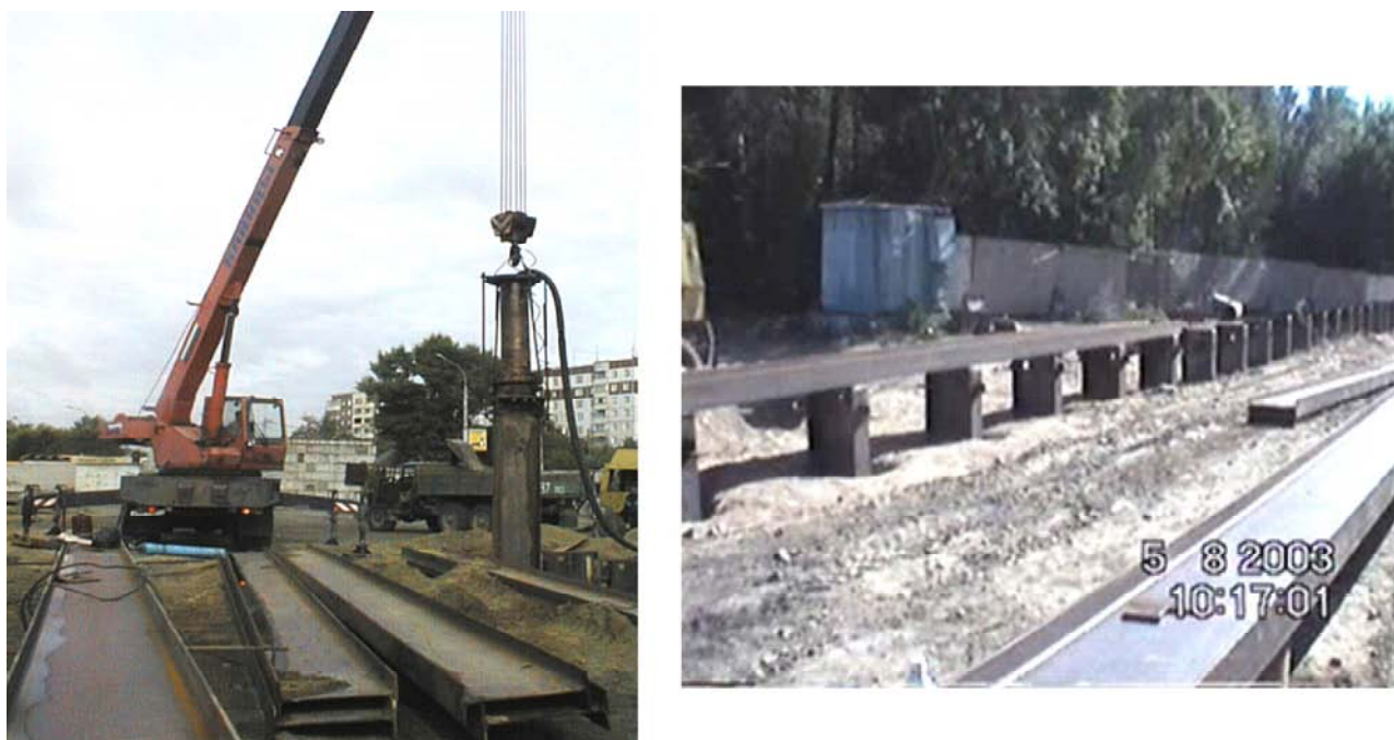
Рис. 9. Сооружение подпорной стены в грунте при строительстве станции метро “Березовая роща” в Новосибирске открытым способом
