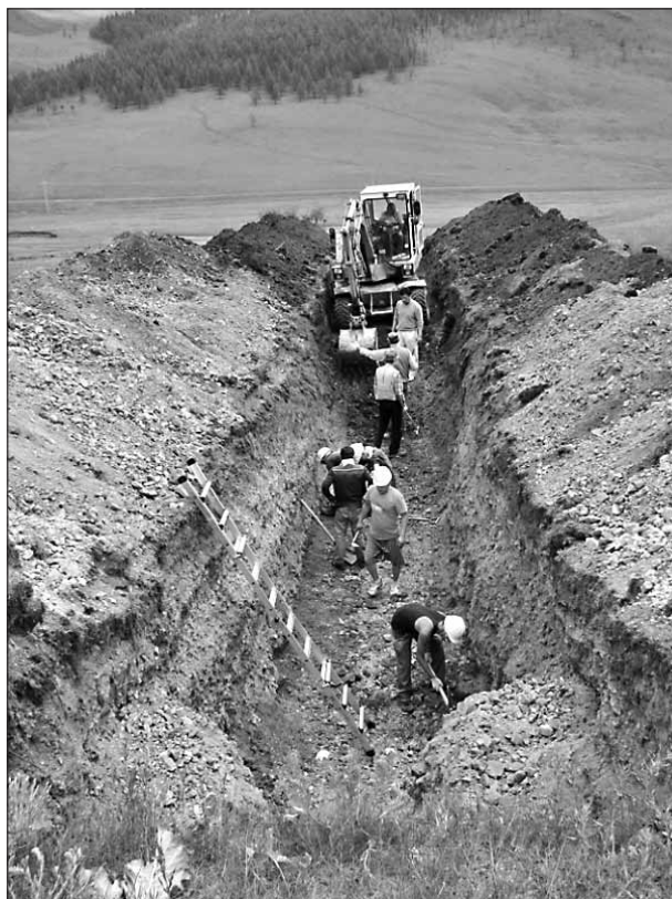
Рис. 4. После проходки российские и монгольские специалисты ведут работы по очистке забоя и выравниванию стенок канавы.
