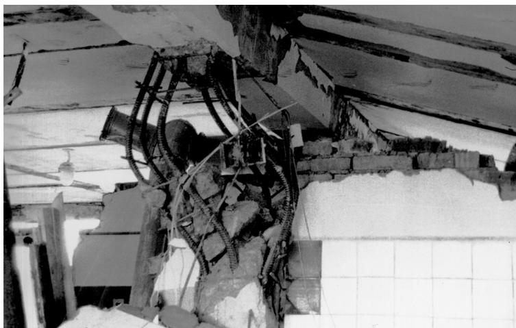
Рис. 1. Разрушение средней сборной железобетонной колонны первого этажа здания комбината бытового обслуживания в пос. Горячие Ключи (о-в Итуруп) в результате землетрясения силой 7,9 баллов
